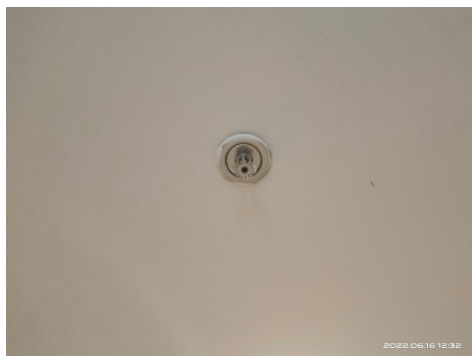
รูปที่ 29 ระบบหัวกระจายน้ำดับเพลิงอัตโนมัติ
