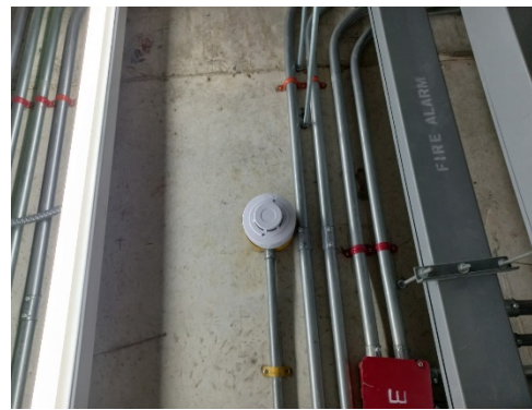
รูปที่ 22 เครื่องตรวจจับควัน (Smoke Detector)
